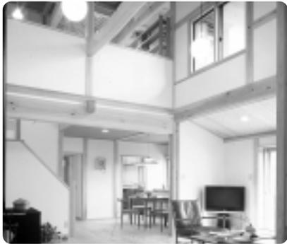
この「自然素材・香りの家」の特色はパッシブソーラーハウス・エアパス工法を採用し、冷暖房に頼った高气密・高断熱住宅とは異なり、太陽や風、地熱など自然の力を最大限に生かし「断熱型壁体内通気工法」により、流れる空気と柱や梁、土台を触れさせて湿気を防ぎ、「夏冬可変型」メカニズムによって、夏涼しく、冬暖かい住まい空間を実現しました。
